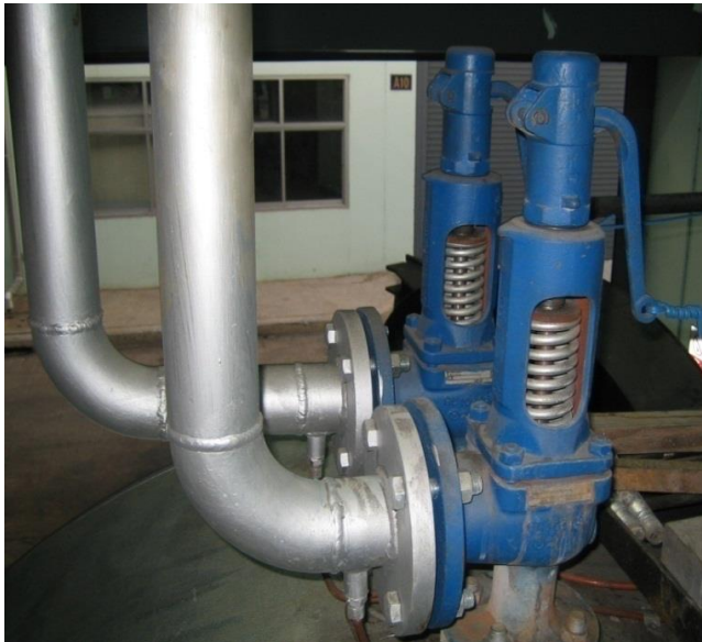
รูปที่ 3.3 การติดตั้งวาล์วนิรภัย (Safety Valve)
