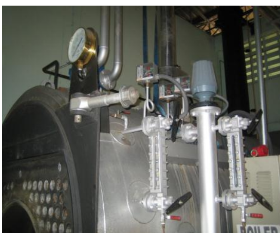
รูปที่ 3.4 การติดตั้งเครื่องวัดระดับน้ำชนิดหลอดแก้ว
