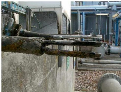
รูปที่ 1-7 สภาพเซ็นเซอร์วัดระดับน้ำในระบบหล่อเย็นที่มีสิ่งสกปรกสะสมอยู่ บริษัท Villers St Sépulcre ประเทศฝรั่งเศส เหตุเกิดเมื่อ 22 กรกฎาคม 2543
