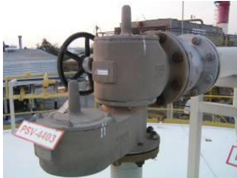
รูปที่ 3-4 วาล์วระบายอากาศ (Breathable Valve)
