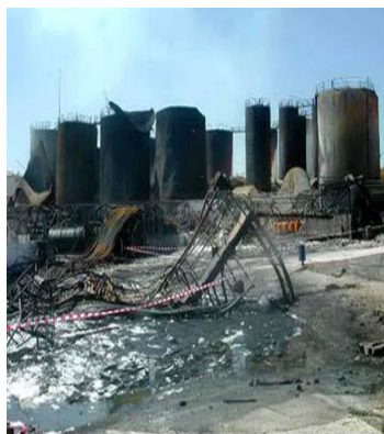
รูปที่ 1-6 ความเสียหายจากการเกิดเพลิงไหม้และระเบิด ของถังเก็บไวนิลอะซีเตตมอนอเมอร์ เหตุเกิดเมื่อ 3 สิงหาคม 2514
