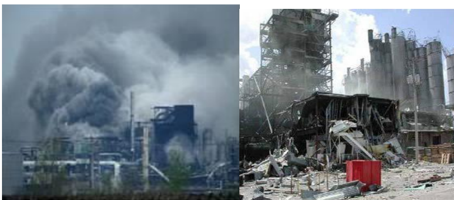
รูปที่ 1-5 ความเสียหายจากการระเบิดและลุกติดไฟของถังปฏิกรณ์ผลิตพีวีซีเรซิน บริษัท Formosa Plastics Corporation รัฐอิลลินอยด์ ประเทศสหรัฐอเมริกา เหตุเกิดเมื่อ 23 เมษายน 2547
