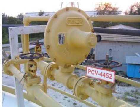
รูปที่ 3-2 วาล์วควบคุมก๊าซไนโตรเจนติดตั้งบนถัง
