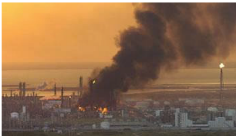
รูปที่ 1-9 ความเสียหายจากการระเบิดและเพลิงไหม้ถังเก็บเอทิลีนไดคลอไรด์ บริษัท Formosa Plastics Corp ในมลรัฐเท็กซัส ประเทศสหรัฐอเมริกา เหตุเกิดเมื่อ 4 ธันวาคม 2541
