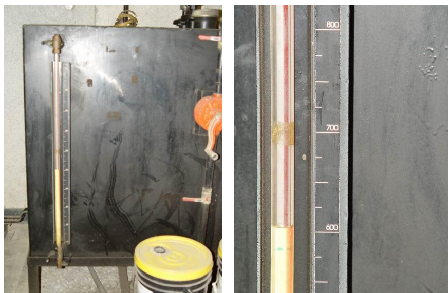
รูปที่ 4.10 ตัวอย่างการตรวจสอบปริมาณน้ำมันสำรองของเครื่องกำเนิดไฟฟ้า
