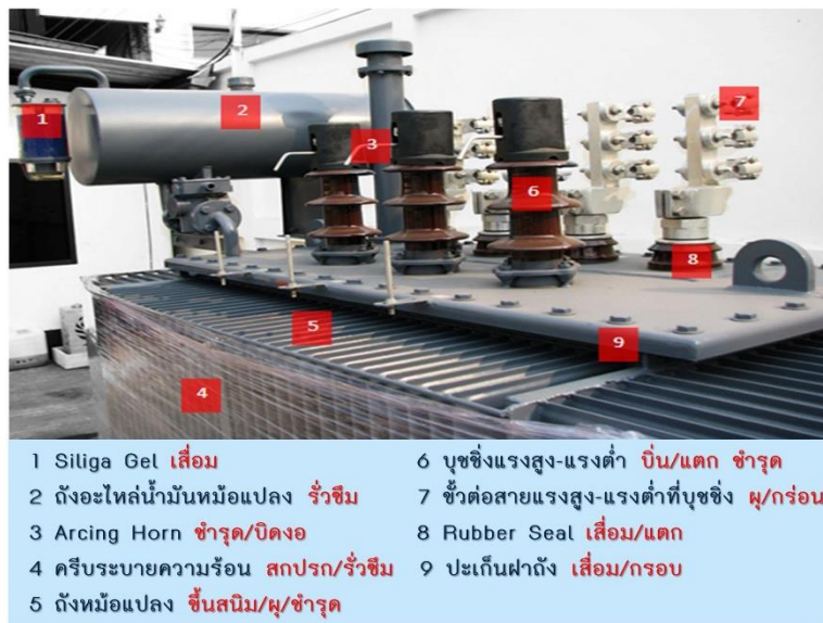
รูปที่ 4.4 ตัวอย่างการตรวจสอบสภาพตัวถังหม้อแปลง
