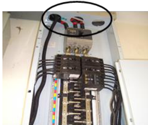
รูปที่ 2.8 การป้องกันกระแสเหนี่ยวนำเมื่อเดินสายผ่านรูของแผ่นโลหะ
