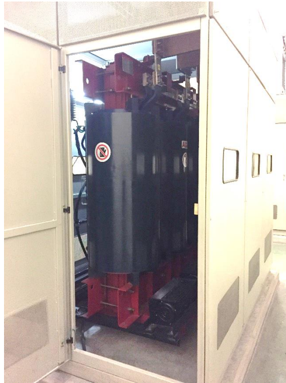
รูปที่ 4.8 ตัวอย่างการตรวจสอบหม้อแปลงไฟฟ้าชนิดแห้ง
