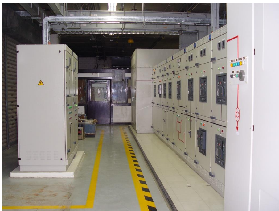
รูปที่ 4.15 ตัวอย่างการตรวจสอบที่ว่างเพื่อปฏิบัติงานของตู้เมนสวิตช์
