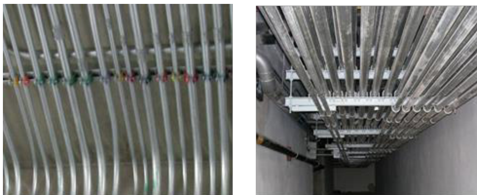
รูปที่ 2.50 ตัวอย่างการจับยึดท่อแบบต่าง ๆ
