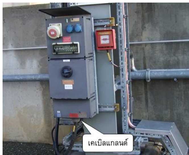
รูปที่ 3.10 การติดตั้งใช้งานเคเบิลเกลนด์
