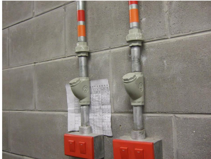
รูปที่ 3.7 ตัวอย่างการปิดผนึกท่อก่อนเข้าสวิทช์ซึ่งติดตั้งนอกบริเวณอันตราย
