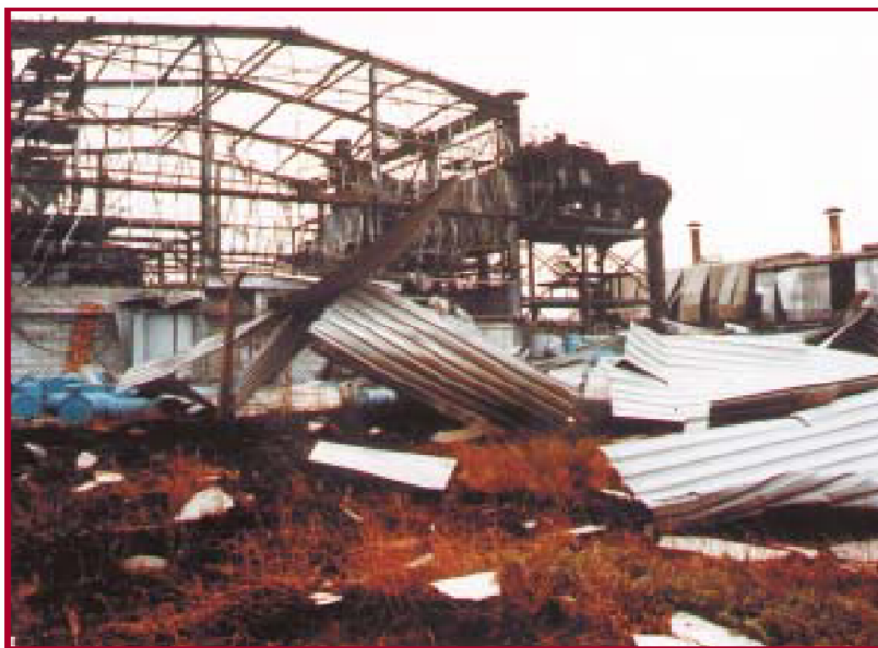
รูปที่ 1-3 ภาพผลจากการระเบิดในโรงงานที่ผลิตผงอลูมิเนียม เนื่องจากไฟฟ้าสถิตย์
