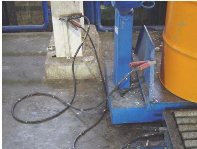
รูปที่ 8-8 การต่อฝากและต่อลงดินของฐานรองรับภาชนะบรรจุ เพื่อให้ประจุไฟฟ้าสถิตย์ที่เกิดขึ้นขณะทำการเก็บไหลลงสู่ดิน
