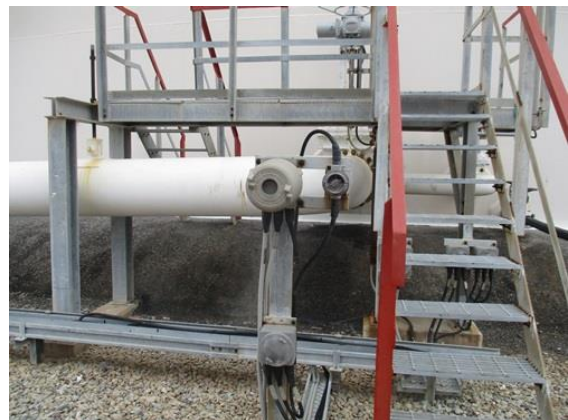
Bottom Tank ATG
