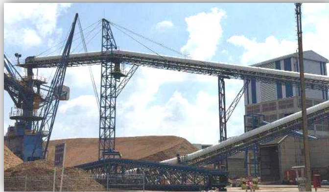
รูปที่ 2 ระบบสายพานลำเลียงเชื้อเพลิง
