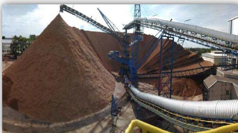
รูปที่ 1 กองเก็บเชื้อเพลิงกลางแจ้ง
