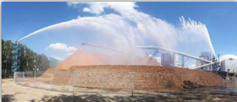
รูปที่ 8 ระบบดับเพลิงฉีดน้ำได้กระจายและครอบคลุมพื้นที่กองเก็บชีวมวล
