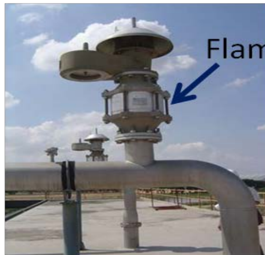
วาล์วแบบใช้ตุ้มน้ำหนักกดลิ้นวาล์ว
