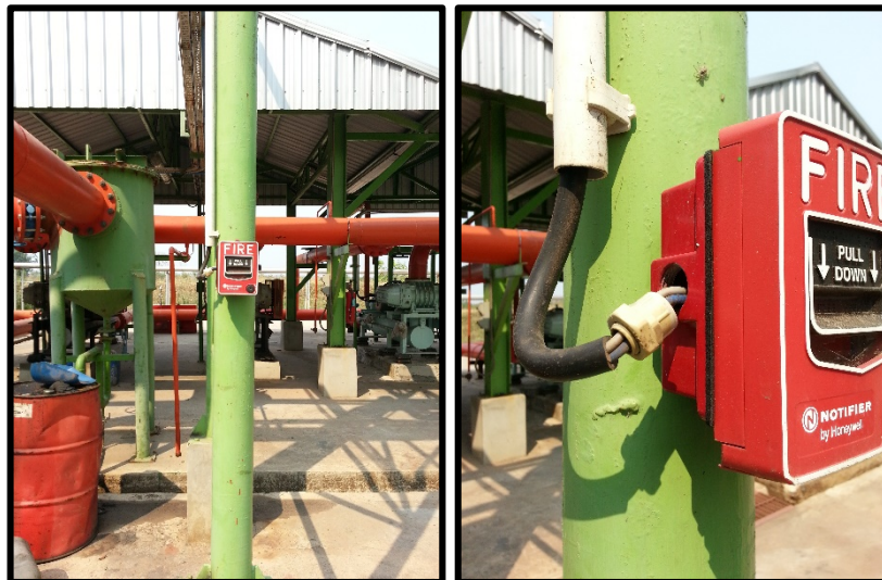
ระบบแจ้งเหตุเพลิงไหม้รอบๆ ถังก๊าซ ชีวภาพ
