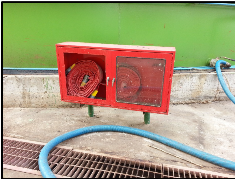
ตู้เก็บสายฉีดน้ำดับเพลิงบริเวณถัง ก๊าซชีวภาพ
