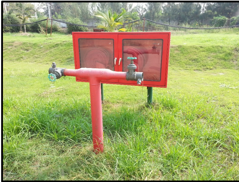
ระบบป้องกันอัคคีภัยรอบๆ ถังก๊าซ ชีวภาพ
