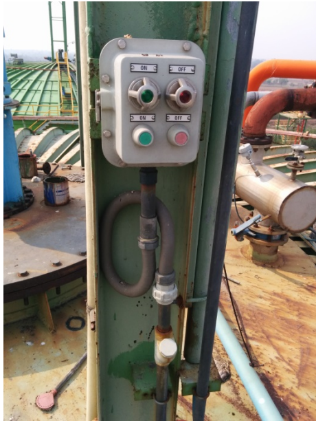
การติดตั้งทางไฟฟ้าบริเวณไซน 1
