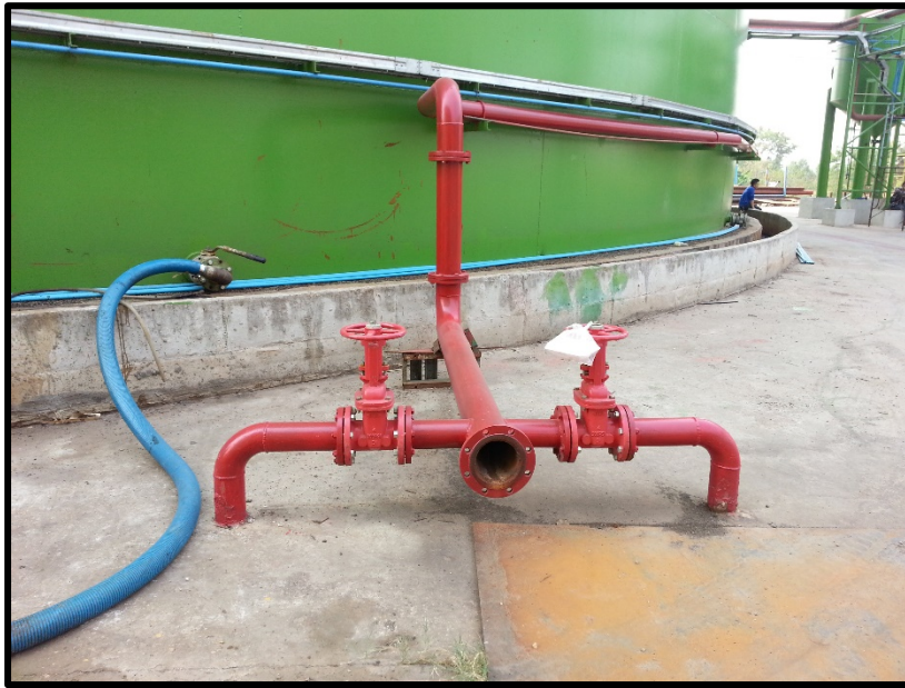
หัวต่อดับเพลิงบริเวณถังก๊าซชีวภาพ
