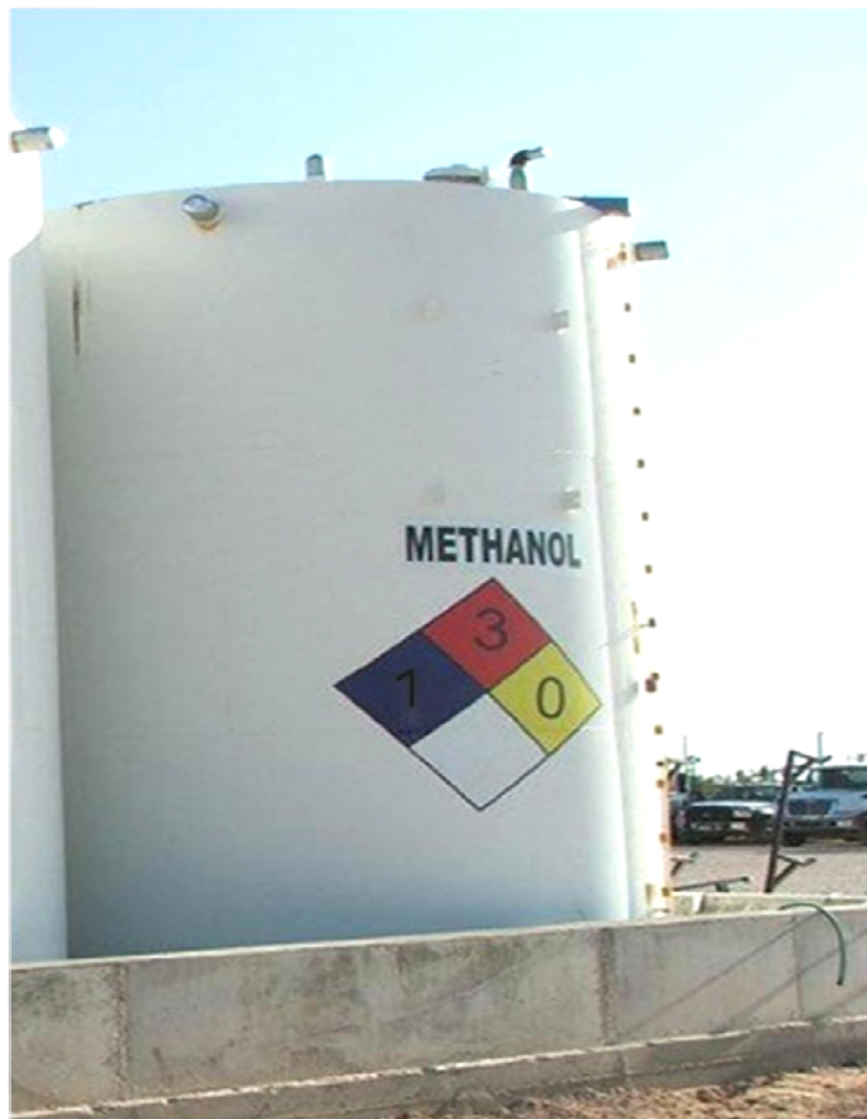
รูปที่ 1.3 ตัวอย่างการติดป้ายแสดงความเป็นอันตรายบนถังเก็บสารเคมีตามมาตรฐาน NFPA
