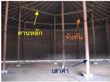
Supported cone roof แบบ 1
