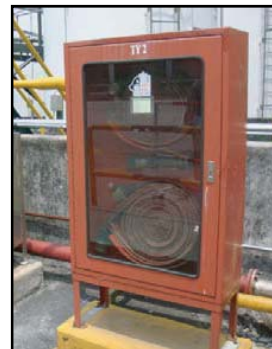
อุปกรณ์ชุดน้ำดับเพลิงประกอบด้วยหัวฉีดน้ำดับเพลิงและสายดับเพลิง
