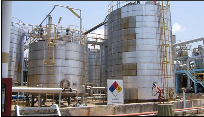
รูปที่ 3-3 ถังเก็บฟอร์มัลดีไฮด์ในโรงงาน
