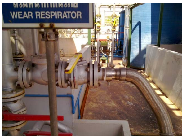
รูปที่ 5-3 ตัวอย่างการต่อท่อเพื่อขนถ่ายฟอร์มัลดีไฮด์จากรถแท็งก์เข้าสู่ถังเก็บ
