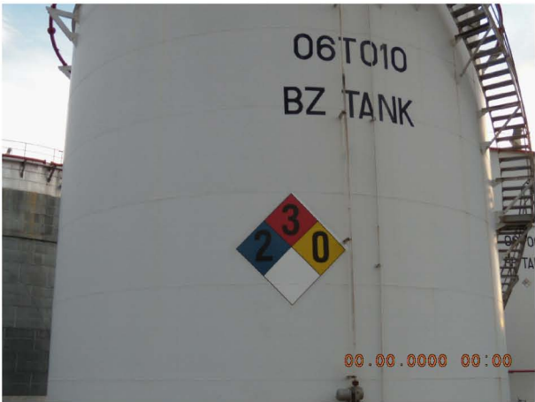
รูปที่ 5-1 ถังเก็บเบนซีน
