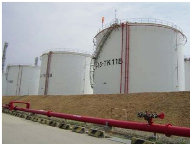
รูปที่ 7-5 ถังเก็บเบนซีนขนาดใหญ่
