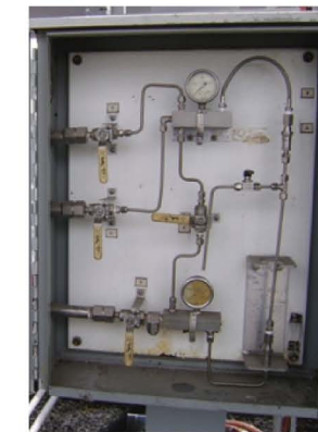
รูปที่ 7-1 การเก็บตัวอย่างเบนซีนในระบบปิด
