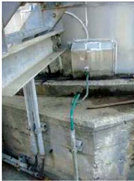
รูปที่ 5-4 การต่อสายดินจากถังเก็บ
