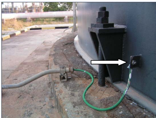
รูปที่ 4-4 การต่อสายดินจากถังเก็บ
