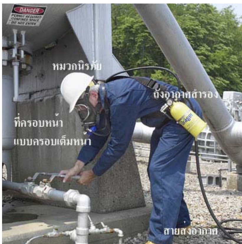
รูปที่ 7-1 อุปกรณ์ปกป้องทางเดินหายใจประเภทจัดส่งอากาศสำหรับการหายใจ พร้อมที่ครอบหน้าแบบครอบเต็มใบหน้า ที่ทำงานในสภาพความดันบวก ใช้ร่วมกับอุปกรณ์ปกป้องทางเดินหายใจชนิดถึงบรรจุอากาศสำรองแบบพกพา
