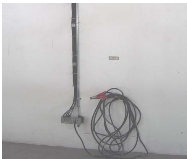
รูปที่ 5.13 อุปกรณ์สายที่ใช้สำหรับการต่อคิบบางชนิดที่มีการถ่ายเทสารไวไฟเพื่อให้ประจุที่เกิดขึ้นระหว่างการถ่ายเทถูกนำลงสู่ดิน
