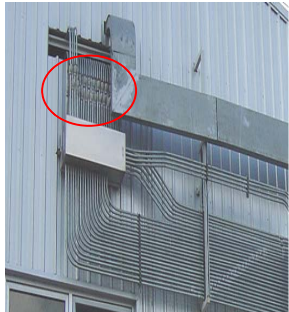
รูปการเดินท่อก่อนเข้าพื้นที่อันตรายของโรงงาน
