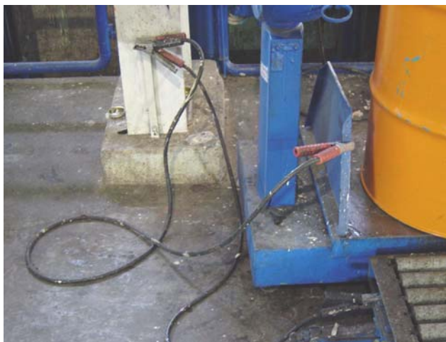
รูปที่ 5.14 การต่อฝากและต่อลงดินของฐานรองรับภาชนะบรรจุสารไวไฟขณะที่ทำการแบ่งบรรจุ เพื่อให้ประจุไฟฟ้าสถิตที่เกิดขึ้นขณะทำการถ่ายเทไหลลงสู่ดิน
