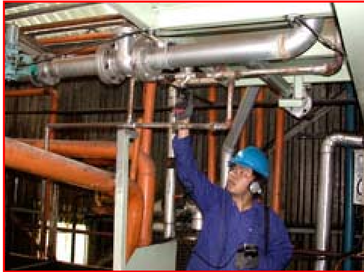
รูปที่ 5-15 แสดงการตรวจวัดตัวสตีมแทรป
