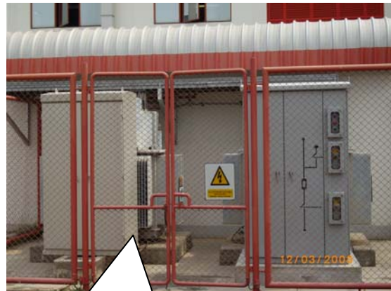
หม้อแปลงตั้งพื้นรับไฟฟ้าจากการเดินสายใต้ดิน
