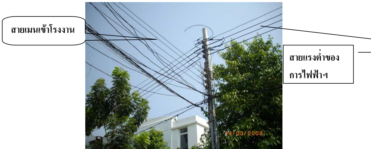
รูปที่ 2.13 แสดงสายแรงต่ำในระบบจำหน่ายของการไฟฟ้าฯ
