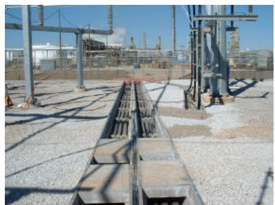
รูปที่ 2.18 แสดงการเดินสายใน Cable Trench
