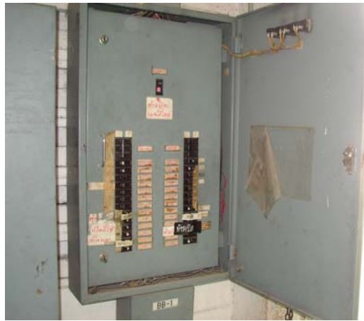
รูปที่ 4.1 แสดงแผงย่อย (Panelboard (PB))
