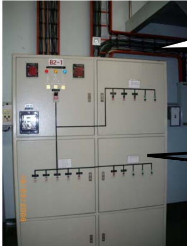
รูปที่ 3.10 แสดงการเดินสายไฟฟ้าแรงต่ำจากแผงสวิตช์ (DB) ไปโหลดหรือแผงย่อย (PB)
