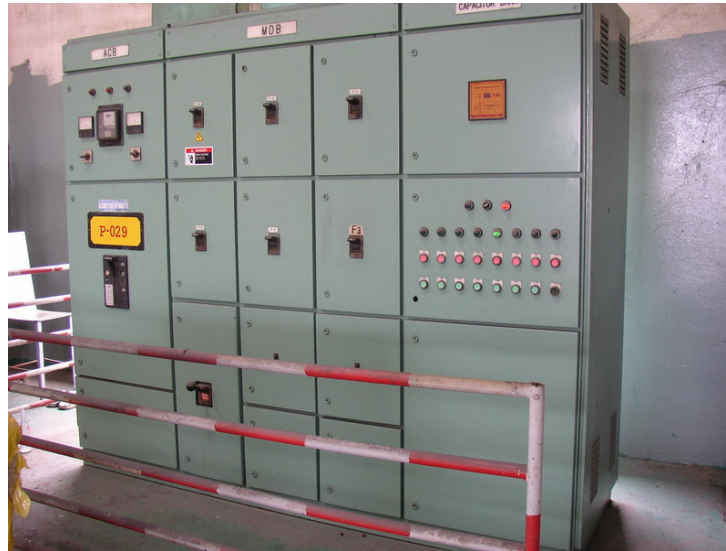
รูปที่ 2.19 แสดงตู้สวิตช์ประธาน (Main Distribution Board (MDB))
