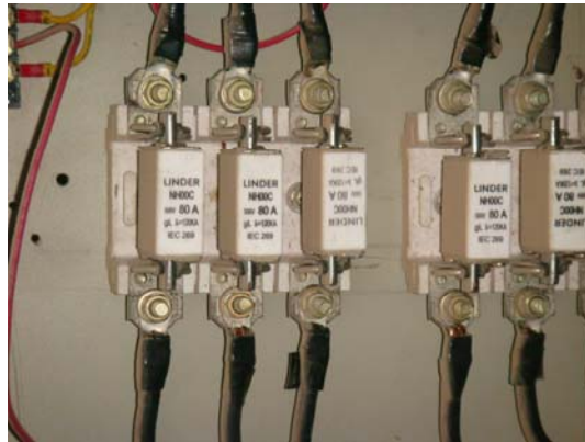
รูปที่ 2.24 แสดงฟิวส์แรงต่ำ
