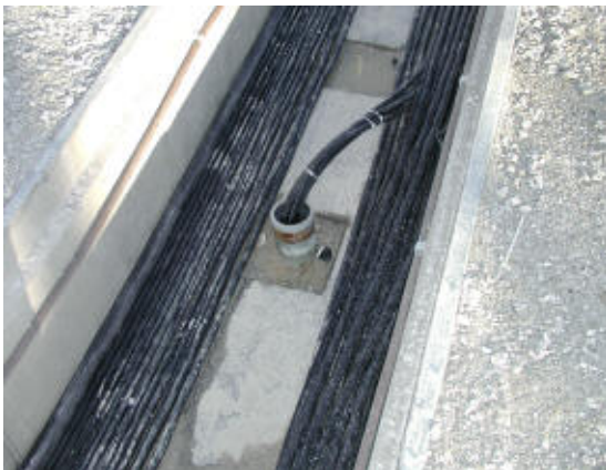
รูปที่ 2.18 แสดงการเดินสายใน Cable Trench
