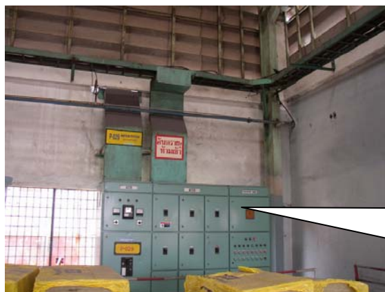
รูปที่ 3.6 แสดงการเดินสายไฟฟ้าแรงต่ำจากหม้อแปลงไฟฟ้าไปตู้สวิตช์ประธาน
