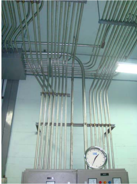
รูปที่ 2.15 แสดงการเดินสายร้อยท่อโลหะชนิด EMT ภายในโรงงาน
