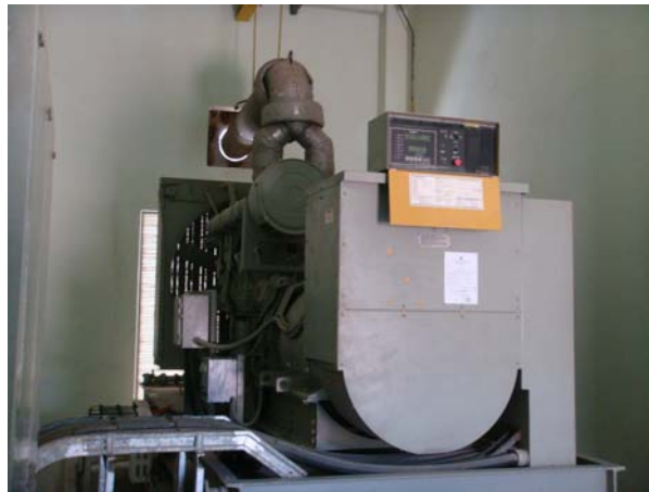
รูปที่ 2.33 แสดงชุดเครื่องกำเนิดไฟฟ้า
