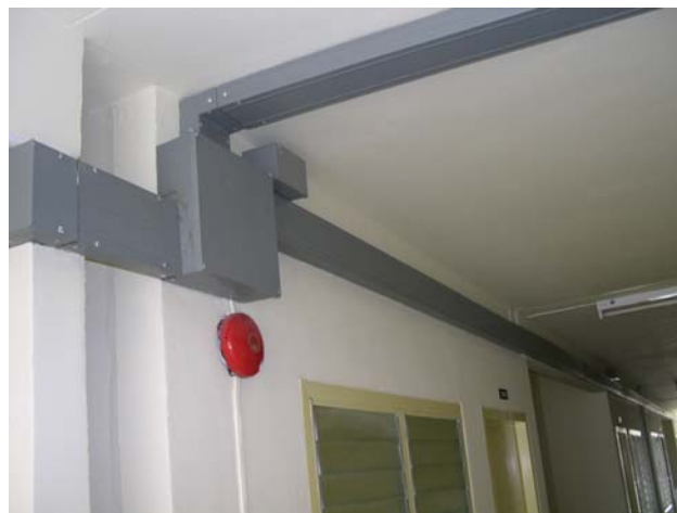
รูปที่ 2.16 แสดงการติดตั้งรางเดินสาย
