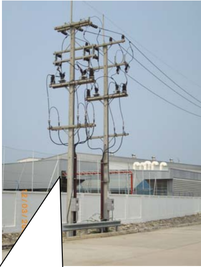
สายไฟฟ้าแรงสูงแบบเดินสายใต้ดิน
