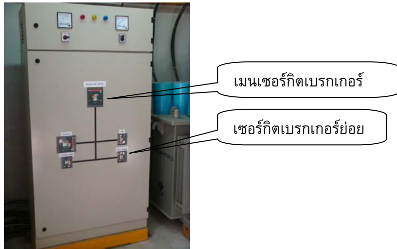
รูปที่ 2.35 แสดงแผงสวิตช์ (Distribution Board (DB))
