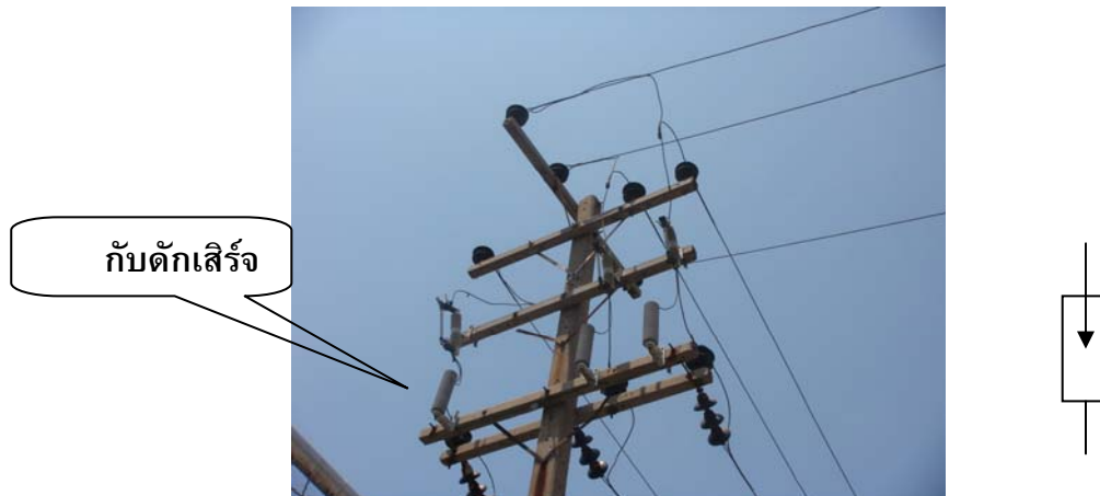
รูปที่ 2.10 แสดงกัปดักเสิร์จที่ติดตั้งใช้งานและสัญลักษณ์
