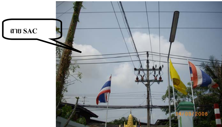
รูปที่ 2.2 แสดงสายหุ้มฉนวนแรงสูง 2 ชั้น ไม่เต็มพิกัด (SAC) ระดับแรงดัน 24 kV
