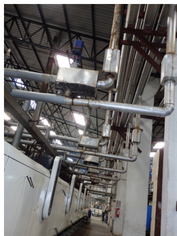
ภาพแสดงการติดตั้งวาล์วควบคุม (Three Way Valve)
