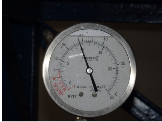
รอยเคาะ ตอก บริเวณแนวเชื่อม และความดันแอมโมเนียที่ถัง Receiver Tank (10 Bar)
