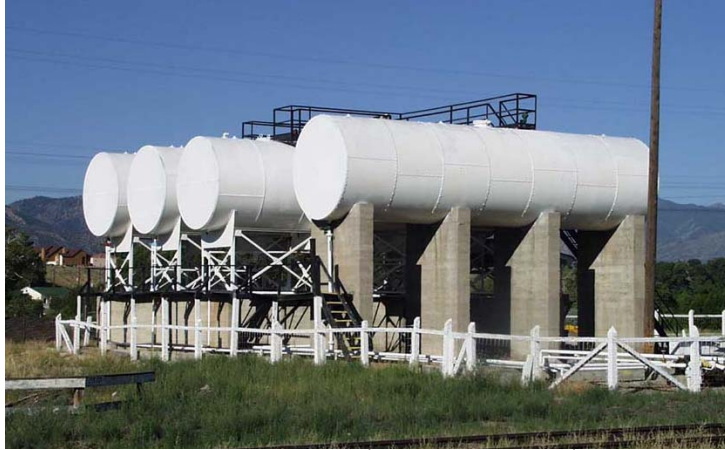
รูปที่ 6.4.2 แสดงถังเก็บเชื้อเพลิงเหลวแบบตั้งบนดิน
