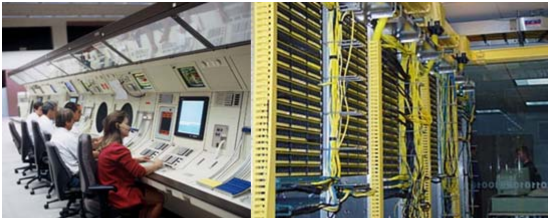
รูปที่ 4.8.1 แสดงพื้นที่ที่ติดตั้งระบบสารสะอาดดับเพลิง
