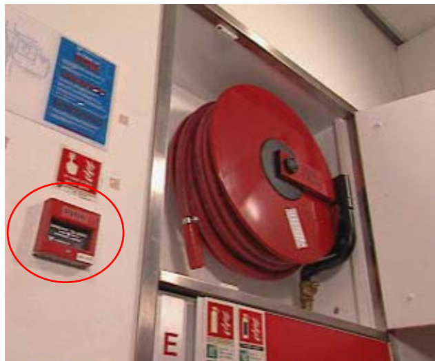
รูปที่ 5.1.3 แสดงการติดตั้งอุปกรณ์แจ้งเหตุแบบมือใกล้กับตู้สายฉีดน้ำดับเพลิง
