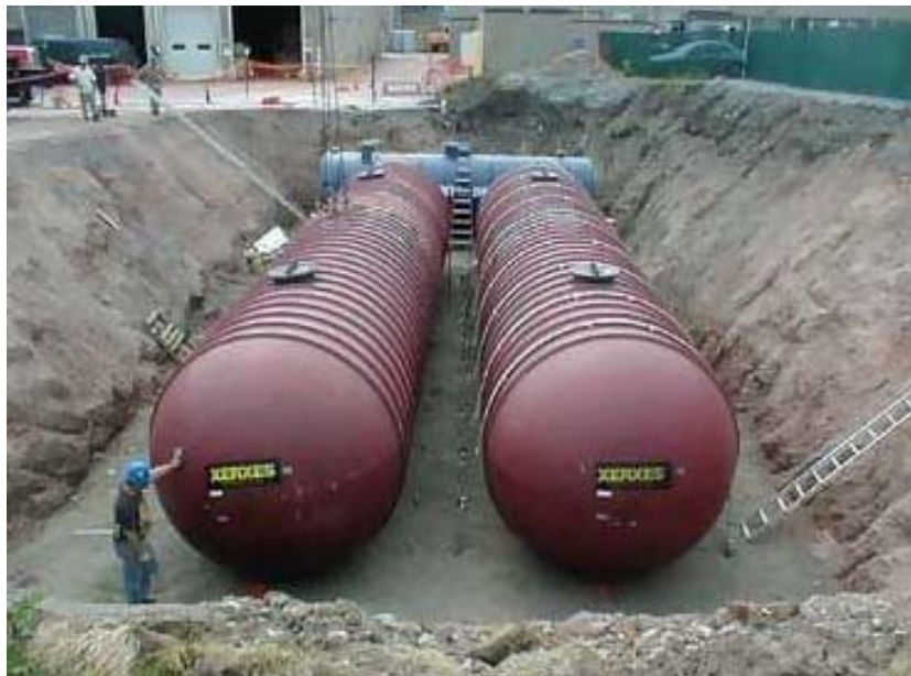
รูปที่ 6.4.1 แสดงการติดตั้งถังใต้ดิน
