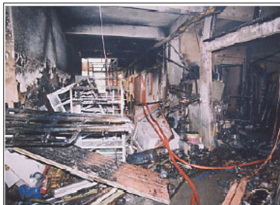
รูปที่ ๔ ภาพความเสียหายของการระเบิดของท่อออกซิเจนเนื่องจากการไม่มีการติดตั้งอุปกรณ์ป้องกันไฟย้อนกลับ
