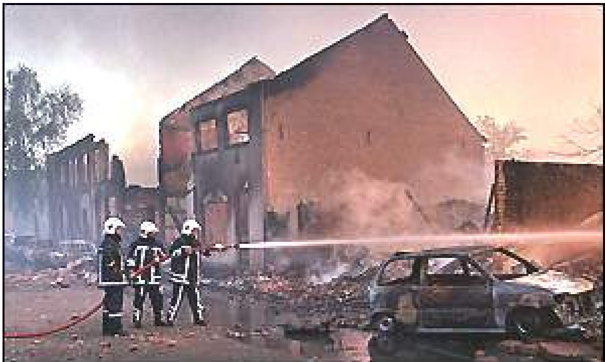
ภาพแสดงความเสียหายของโรงงานผลิตดอกไม้เพลิง
