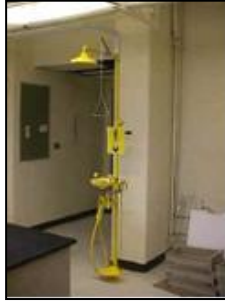
รูปที่ 16 อ่างล้างตาและที่ล้างตัวฉุกเฉิน
