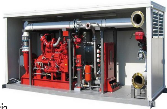
รูปที่ 10 ระบบน้ำดับเพลิง
