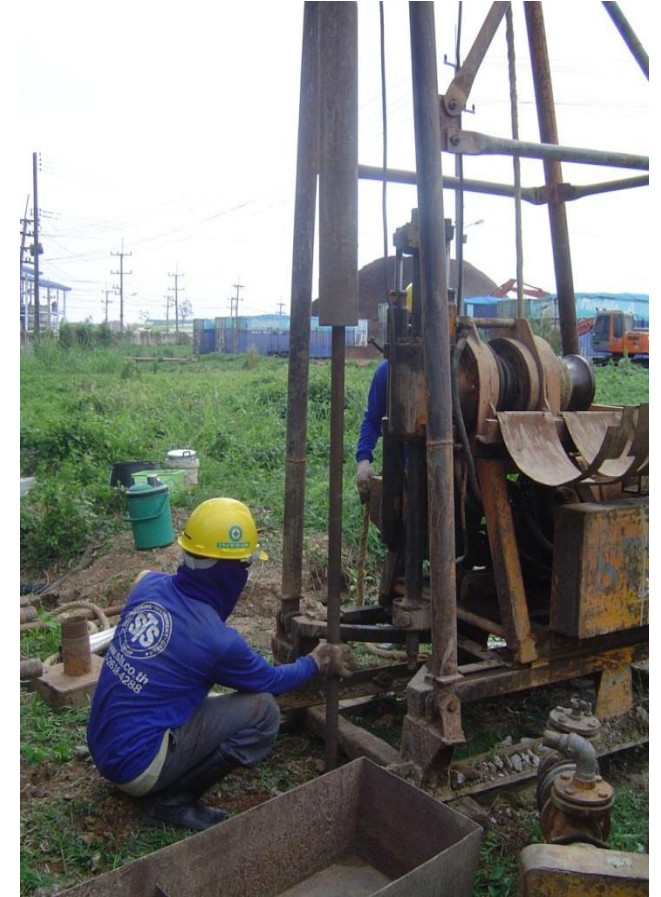
เครื่องจักรขุดเจาะ ปั่นจั่น
