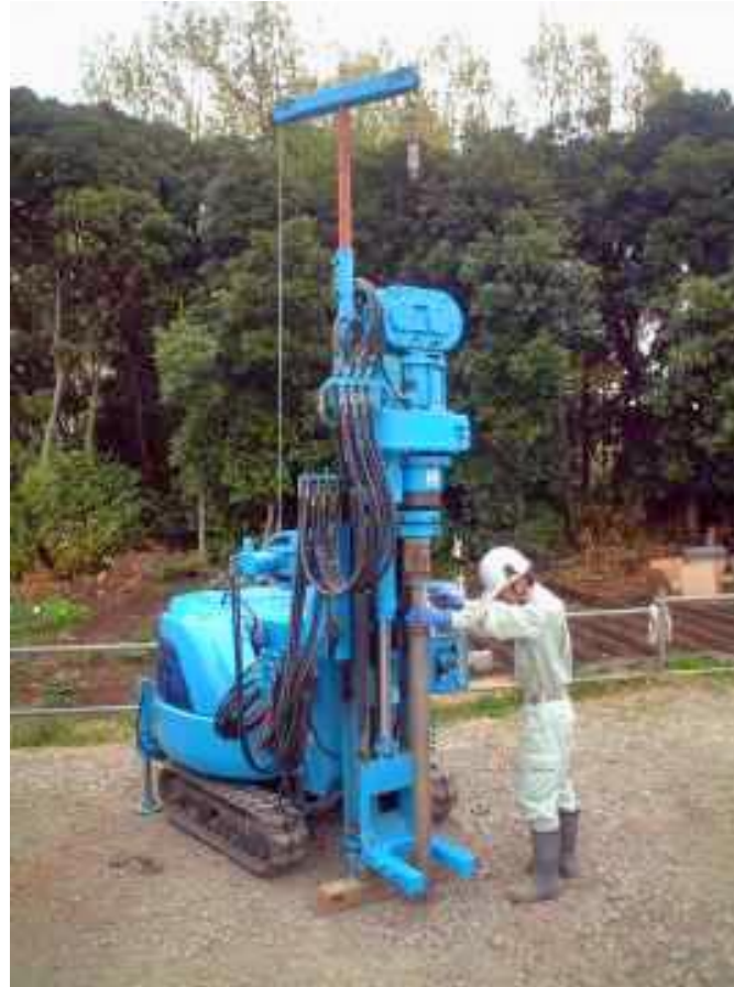
เครื่องจักรขุดเจาะ ต้มน้ำหนักที่ใช้ตอก
