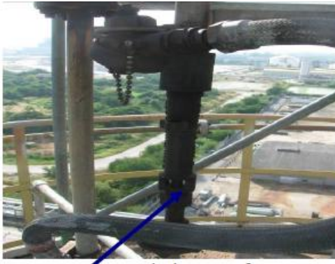
รูปที่ 4-7 ตัวอย่าง Orifice ที่ต้องทำการถอดล้าง
