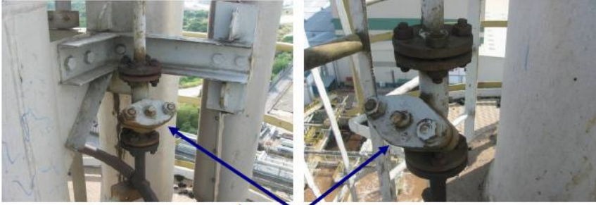
รูปที่ 4-6 ตัวอย่าง Pilot Gas Strainer
