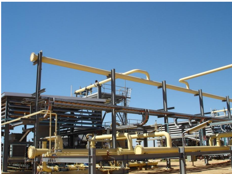
รูปที่ 2-12 ตัวอย่าง Flare Header
