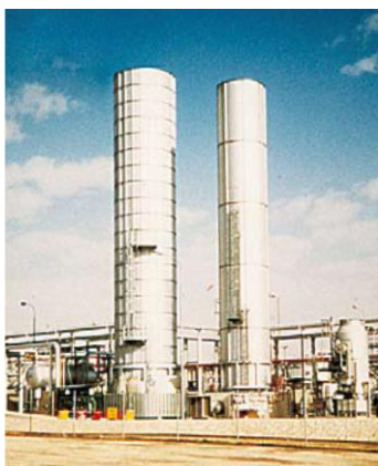
รูปที่ 2-4 ตัวอย่าง Enclosed Ground Flare
