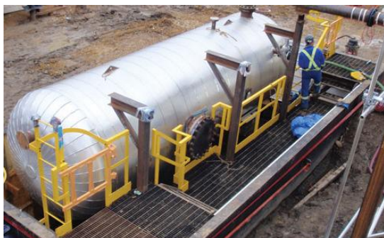
รูปที่ 2-13 ตัวอย่างและการทำงานของ Knock-Out Drum
