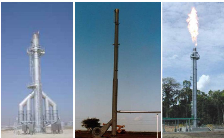
รูปที่ 2-7 ตัวอย่าง Air-assisted Flare
