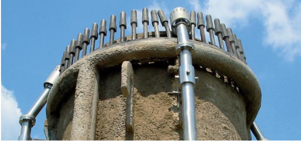
รูปที่ 2-19 ตัวอย่างส่วนประกอบของ Pilot Burners และ Ring Steam Burner
