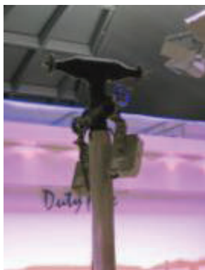
รูปที่ 3.2-27 อุปกรณ์ดับเพลิงด้วยน้ำแบบอัตโนมัติ (Sprinkler)
