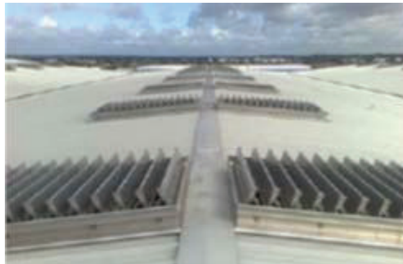
รูปที่ 3.2-46 ตัวอย่างการติดตั้งช่องเปิดระบายควันบนหลังคาของอาคารโรงงาน
