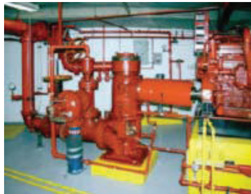
รูปที่ 3.2-24 แสดงตัวอย่างของเครื่องสูบน้ำดับเพลิงแบบเทอร์ไบน์แนวตั้ง
