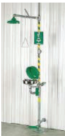
รูปที่ 4.2-5 ฝักบัว และที่ล้างตาฉุกเฉิน
