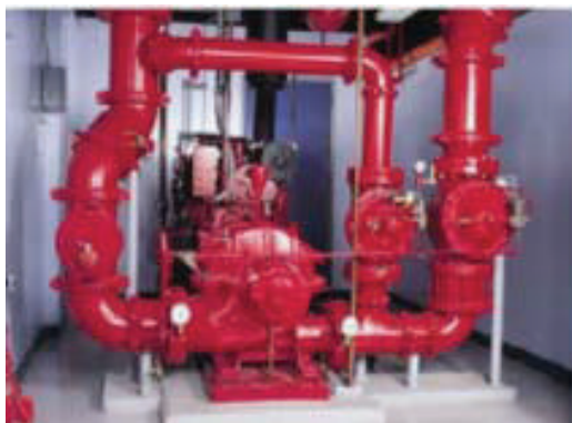
รูปที่ 3.2-23 เครื่องสูบน้ำดับเพลิงชนิดแรงเหวี่ยงหนีศูนย์กลาง แบบ Horizontal Split-Case
