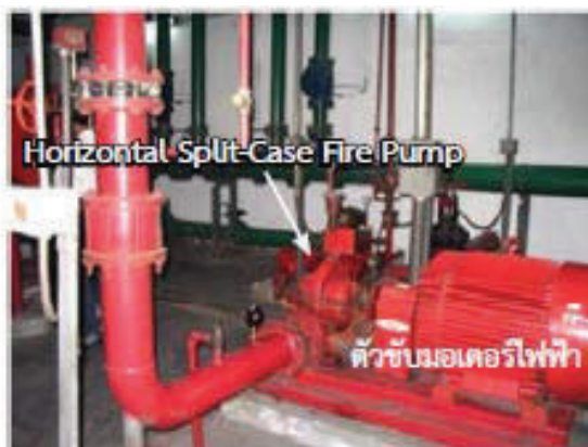
รูปที่ 3.2-25 การขับเครื่องสูบน้ำดับเพลิงด้วยเครื่องยนต์ดีเซล และมอเตอร์ไฟฟ้า
