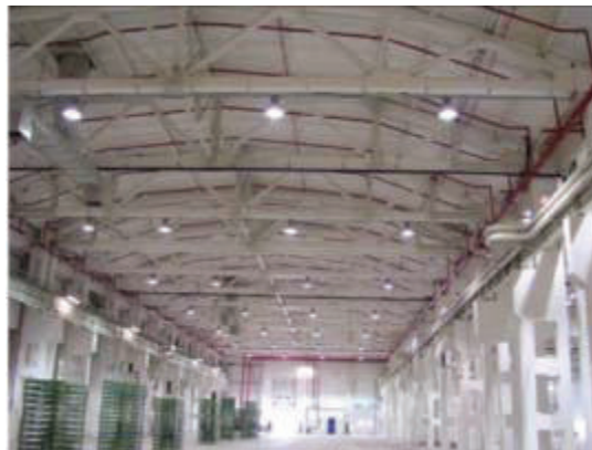
รูปที่ 3.2-45 การติดตั้งระบบหัวกระจายน้ำดับเพลิงอัตโนมัติบนโครงสร้างหลังคาเหล็กของอาคารจัดเก็บสินค้า (Warehouse) เพื่อปกป้องโครงสร้างหลังคาเหล็กจากเพลิงไหม้
