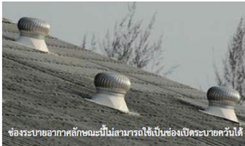
รูปที่ 3.2-48 ช่องระบายอากาศที่หลังคาไม่ถือว่าเป็นช่องเปิดระบายควันไฟตามประกาศนี้ เนื่องจากไม่สามารถทำงานได้ภายใต้อุณหภูมิที่สูงของควันไฟ
