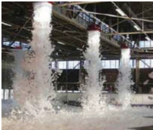
รูปที่ 3.2-36 การทดสอบการทำงานของระบบโฟมดับเพลิงอัตโนมัติ ของอาคารที่ใช้ในการจัดเก็บของเหลวไวไฟ
