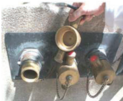
รูปที่ 3.2-22 หัวรับน้ำดับเพลิงชนิดข้อต่อสวมเร็วขนาด 2 1/2 นิ้ว
