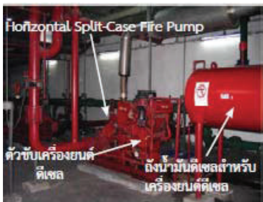
รูปที่ 3.2-25 การขับเครื่องสูบน้ำดับเพลิงด้วยเครื่องยนต์ดีเซล และมอเตอร์ไฟฟ้า
