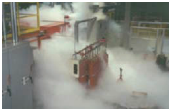
รูปที่ 3.2-28 การทำงานของระบบก๊าซคาร์บอนไดออกไซด์ดับเพลิงตามมาตรฐาน NFPA 12 Standard on Carbon Dioxide Extinguisher Systems
