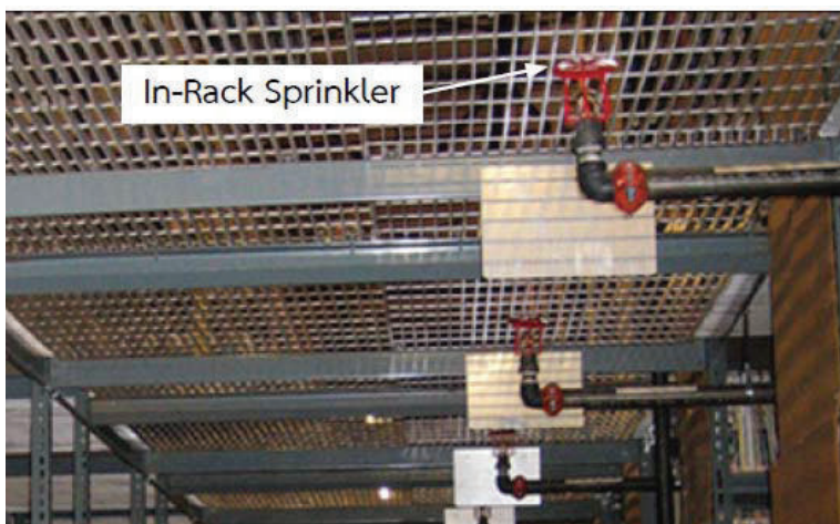
รูปที่ 3.2-34 การติดตั้ง In-Rack Sprinkler บนชั้นวางสำหรับจัดเก็บสินค้า
