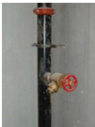
รูปที่ 3.2-18 ท่อยื่นประเภทที่ 1 ประกอบด้วยวาล์วสายฉีดน้ำดับเพลิงขนาด 2½ นิ้ว
