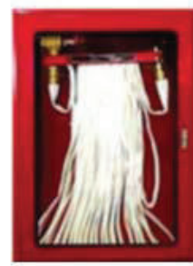
ชุดสายฉีดน้ำดับเพลิงแบบ Hose Rack ขนาด 1½ นิ้ว
