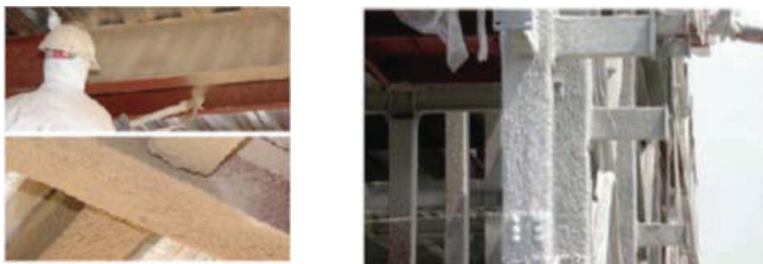
รูปที่ 3.2-43 การป้องกันโครงสร้างเหล็กโดยการพ่นด้วยวัสดุทนไฟ
