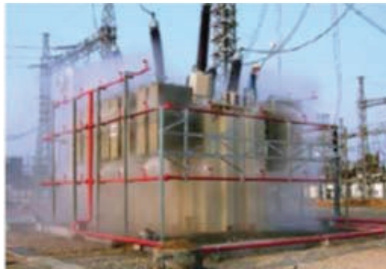
รูปที่ 3.2-33 การทำงานของระบบหัวกระจายน้ำดับเพลิงแบบเปิด เพื่อป้องกันเพลิงไหม้ของหม้อแปลงไฟฟ้าชนิดน้ำมัน
