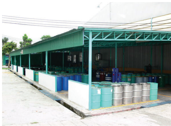
รูปที่ 2.3-6 การจัดเก็บของเสียภายในอาคาร
