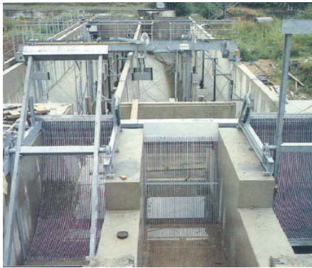
รูปที่ 2.1-2 ตะแกรงแบบแผ่นเอียง
